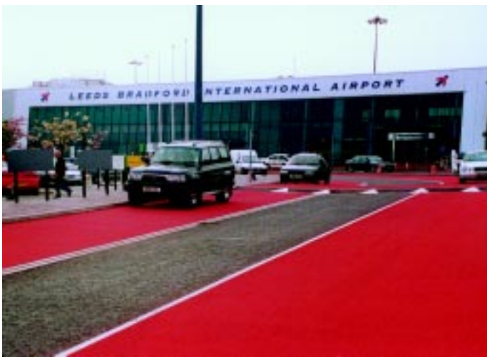
Röd ytbeläggning utförd av Line Markings på asfalt för av- och påstigningszon, Leeds-Bradforfs flygplats.
