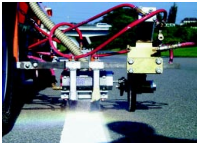
Applicering av vattenburen vägmarkeringsfärg med specialmix av glaspärlor för synbarhet i mörker och vått underlag. (Plastiroute)
