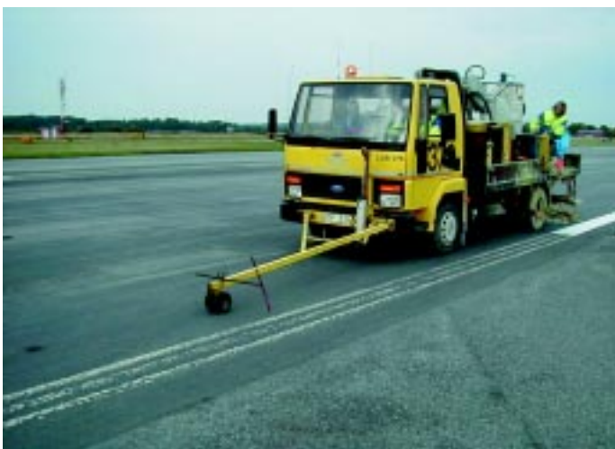
Markering av transportsträckor på Säve Flygplats med Mercialin AQ 6010.
