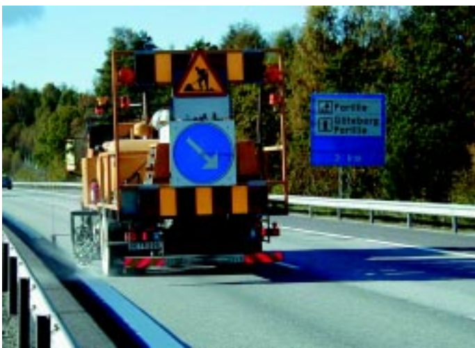
Kantlinjen på E20 norr om Göteborg är markerad med Mercialin AQ 6010 vattenburen vägmarkeringsfärg.
