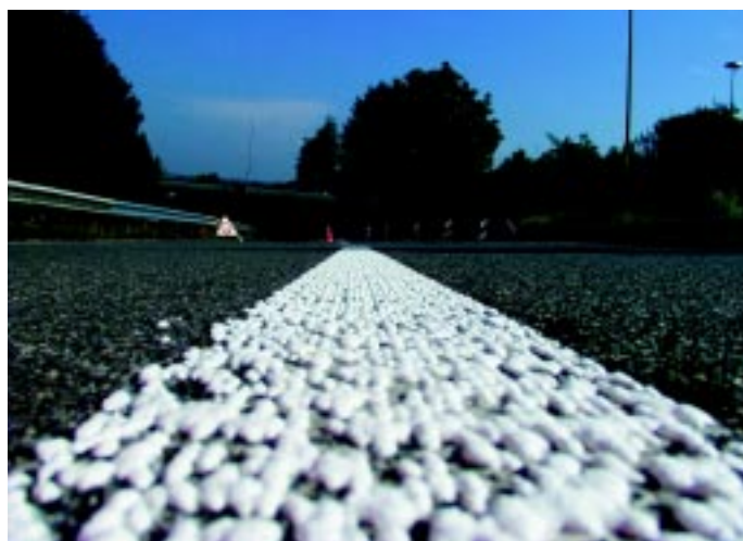
Strukturerad vägmarkering av vattenburen plastmassa för synbarhet i mörker och vått underlag utvecklad av Plastiroute.
