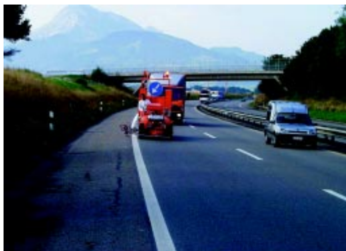
Provläggning med, av Plastiroute utvecklat, vattenburet system för synbarhet i mörker och vått underlag och för ökad hållbarhet.
