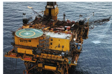
Heather-plattformen i UK
