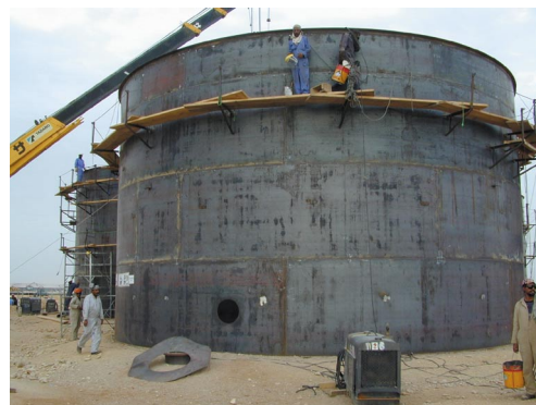
Byggearbeider ved prosessanlegget på Tasour-feltet
