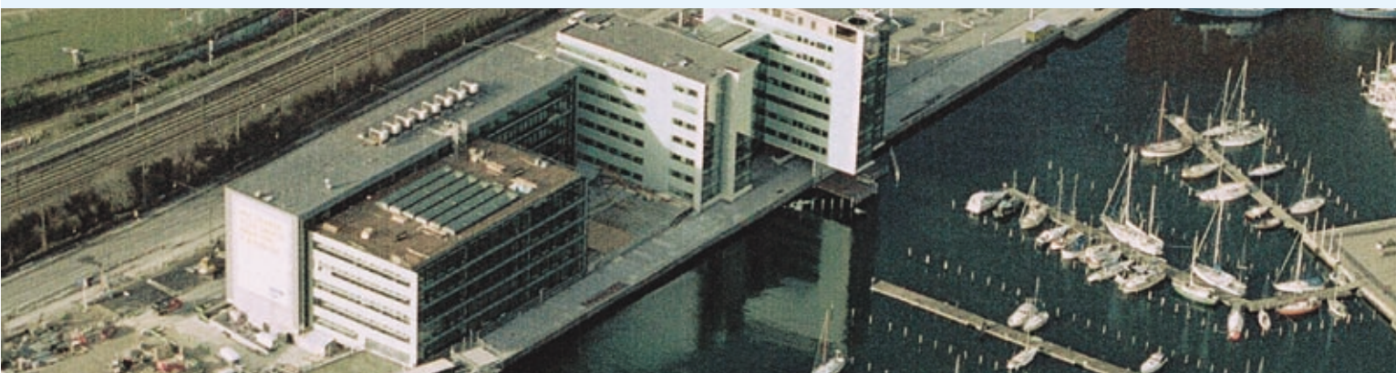
Tiscali og SAP, Kalkbrænderihavnen Opførelse af ialt 13.300 m 2 domicil, tegnet af 3 x Nielsen Arkitektfirma A/S. Solgt til PFA Pension.
