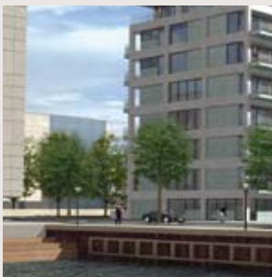
Kajplads 24, Havnestad Syd/Islands Brygge Boligskitseprojekt tegnet af arkitekt Kim Utzon
