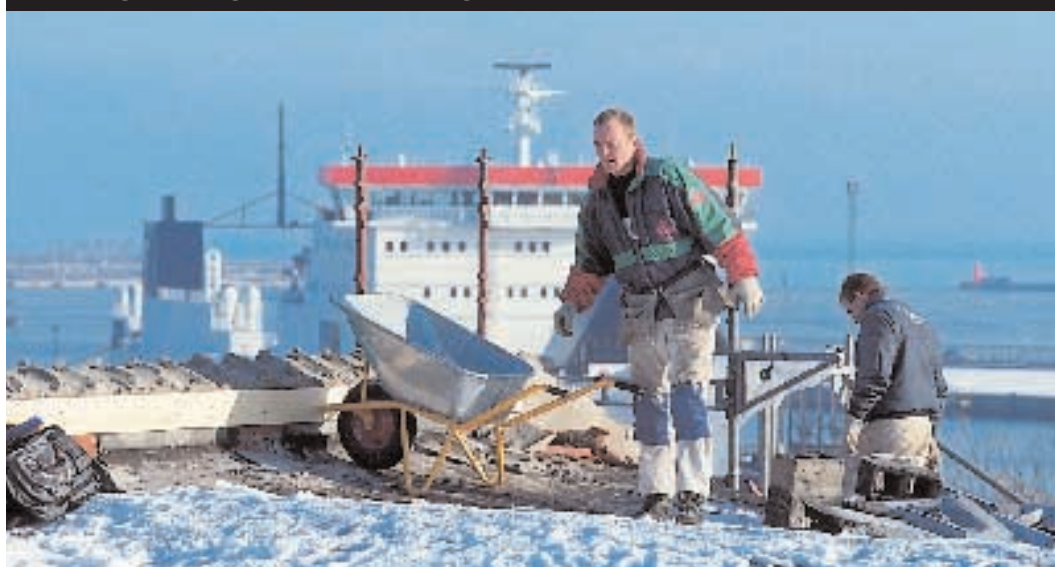
Renovering af det tidligere Nordisk Kaffekompagni til kontorer
