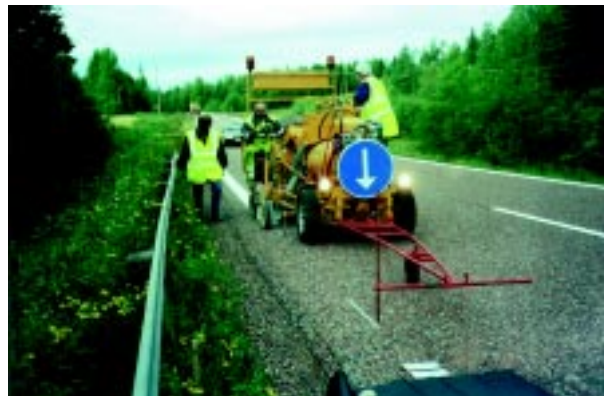
Applicering av Aquaplast på väg 301 i Dalarna. Aquaplast, som består av vattenburen vägmarkeringsfärg appliceras som en strukturerad vägmarkering. Väg 301 ingår i ett nordiskt proofält i samarbete med Svenska Vägverket för utvärdering av vägmarkerings synbarhet i mörker och väta.
