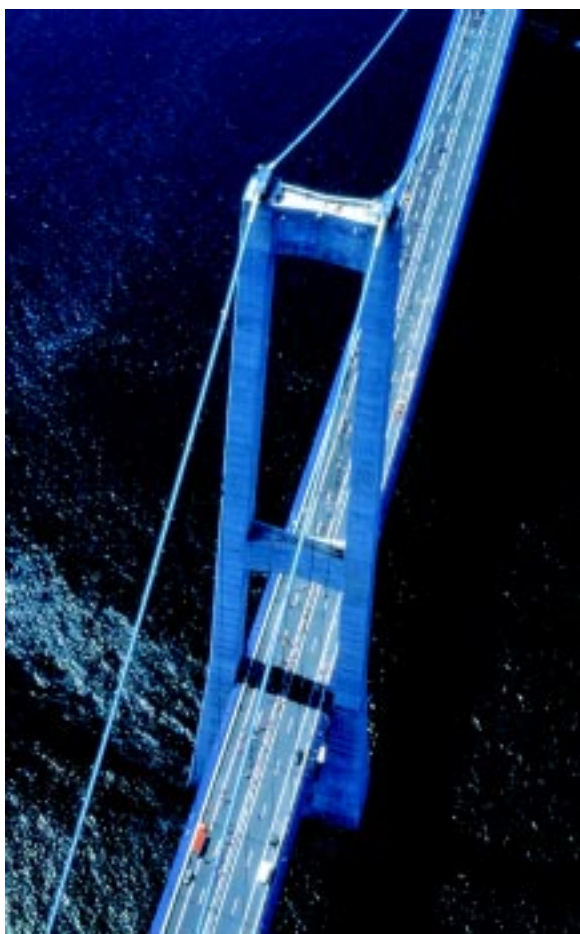
LKF Vägmarkering har utfört markeringarna på Östbron, som ingår i Stora Bältförbindelsen, med termoplastiskt material.
