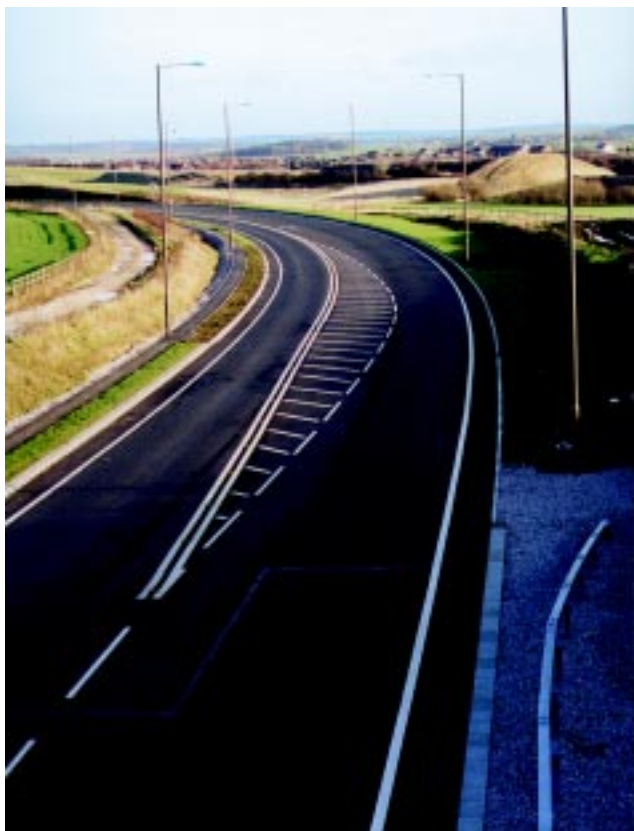
In närheten av Wakefield i Yorkshire, England har en ny vägsträcka anlagts för att undvika genomfartstrafik. Line Marking Ltd (Roadcare) har utfört vägmarkeringarna med termoplastiskt material, s k "Nitebrite".
